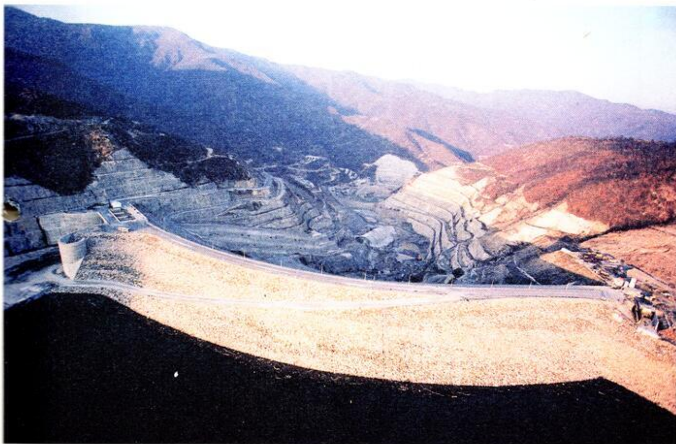
ΦΡΑΓΜΑ ΔΕΗ ΘΗΣΑΥΡΟΥ
