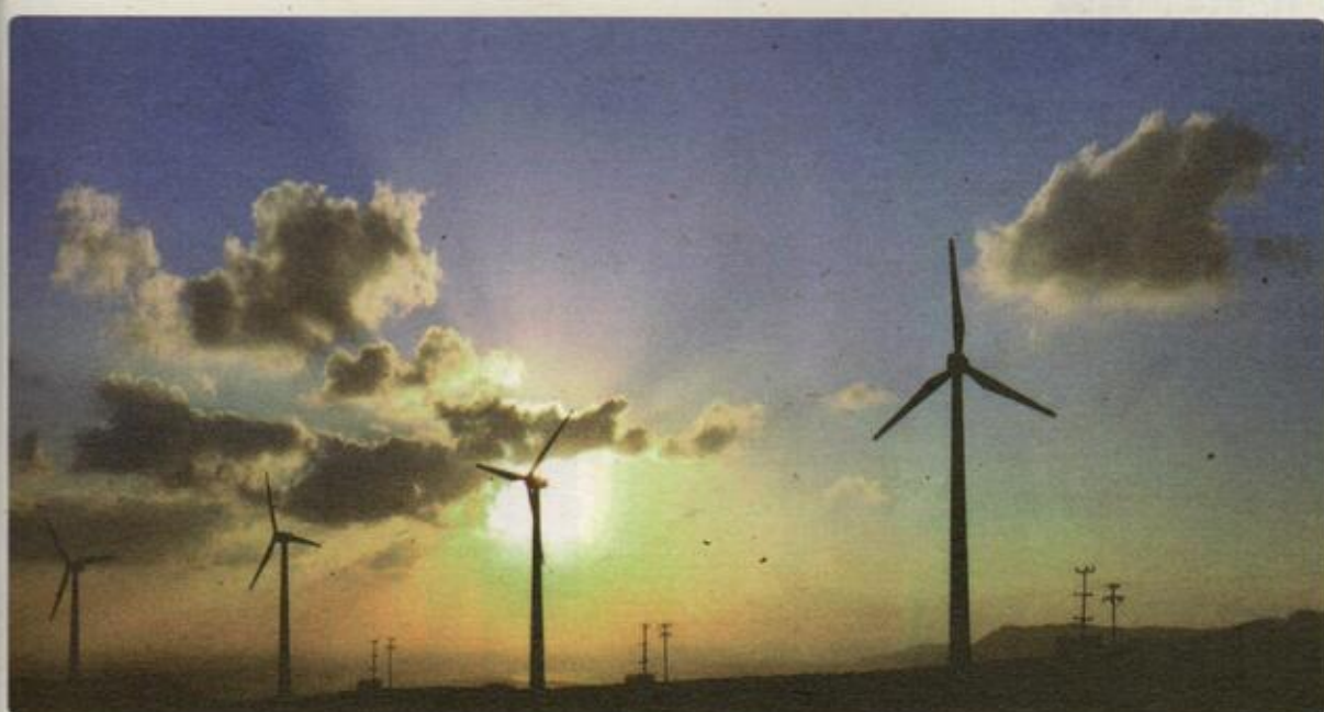
Αιολικό Πάρκο Μονής Τοπλού, Σητεία. Η δυναμική επέκταση στις Ανανεώσιμες Πηγές Ενέργειας, με επενδύσεις € 2 δισ., αποτελεί στρατηγικό στόχο του Ομίλου ΔΕΗ Α.Ε.
